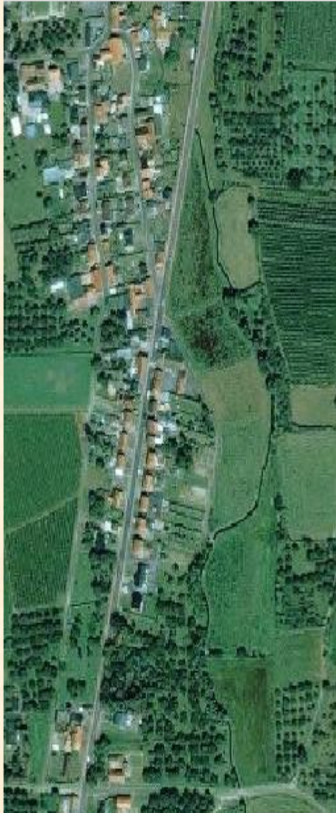
Toestand voor de aanleg
